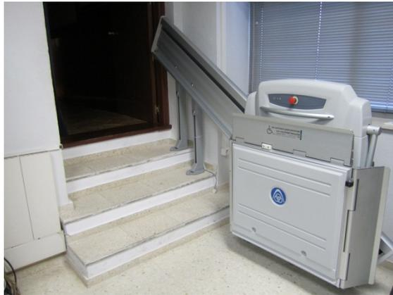
**Imagen 8: Plataforma elevadora de acceso al escenario Salón de Actos del Edificio C de la ETSI Telecomunicación**
