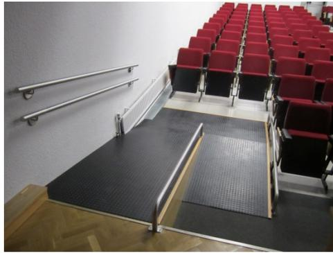
**Imagen 2: Rampa de acceso al estrado del Aula Magna del Edificio A de la ETSI Telecomunicación**
