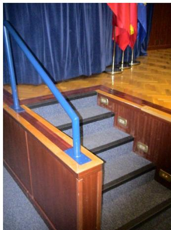
**Imagen 7: Acceso a escenario no accesible del Salón de Actos del Edificio C de la ETSI Telecomunicación**
