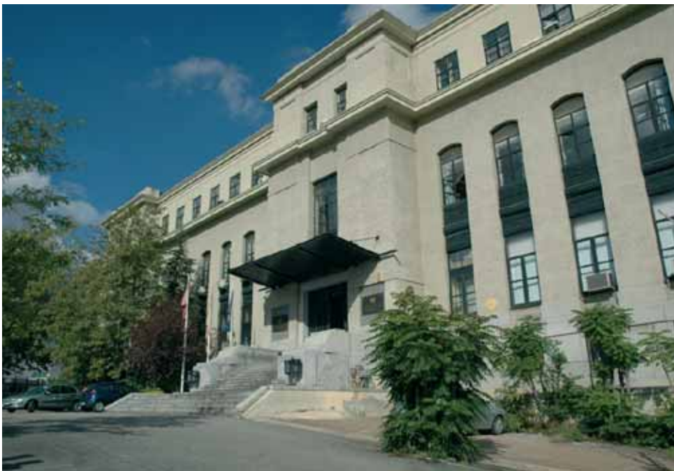
Fachada principal de la EUIT de Obras Públicas.
