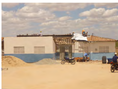
Proceso de construcción de una cisterna.
