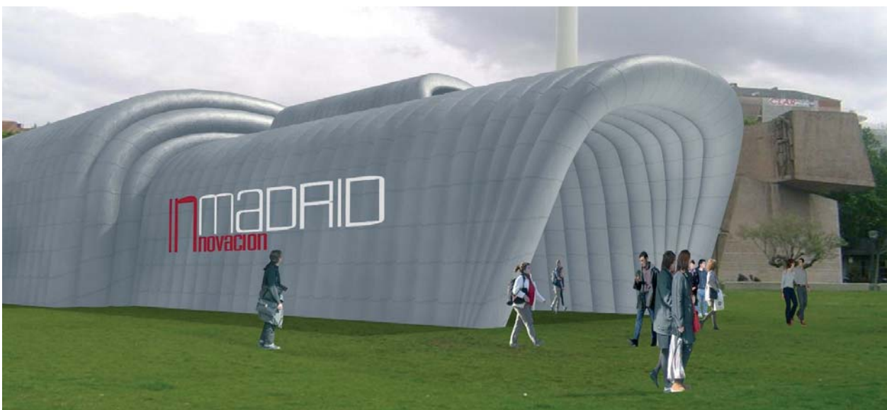
La carpa, instalada en la madrileña Plaza de Colón.
