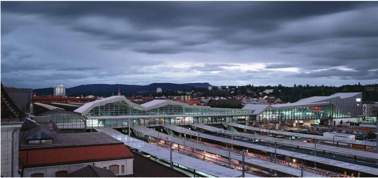
Remodelación de la estación de Basilea, en Suiza.
